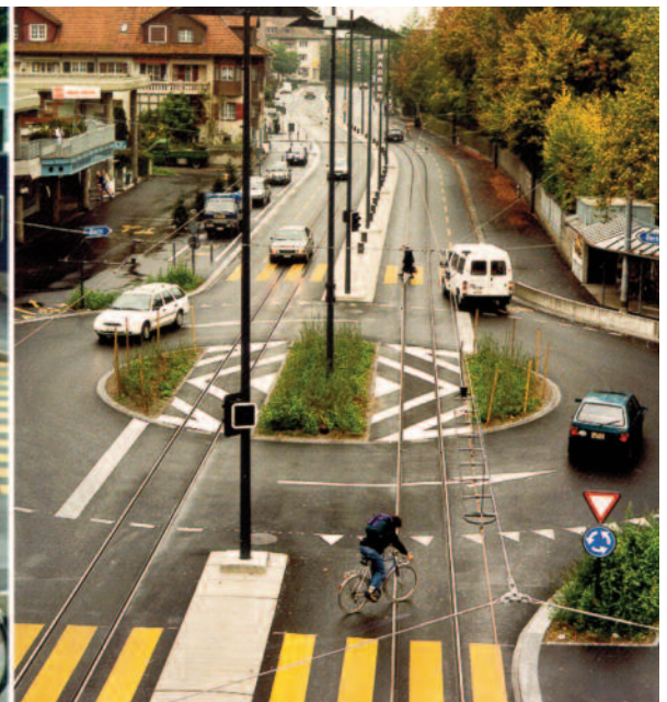
Wabern après l'assainissement
