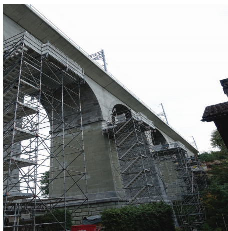
Bauarbeiten Toggelilochbrücke (Agglomeration)
