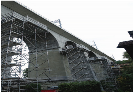
Travaux Toggelilochbrücke (Agglomération)
