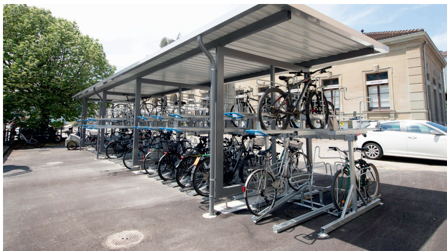
Installation d'une nouvelle vélostation à la gare de Fribourg / © Valérie Brodard
